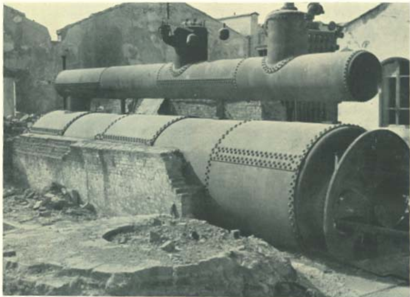
Caldoie dopo un primo smantamento di ricicla
