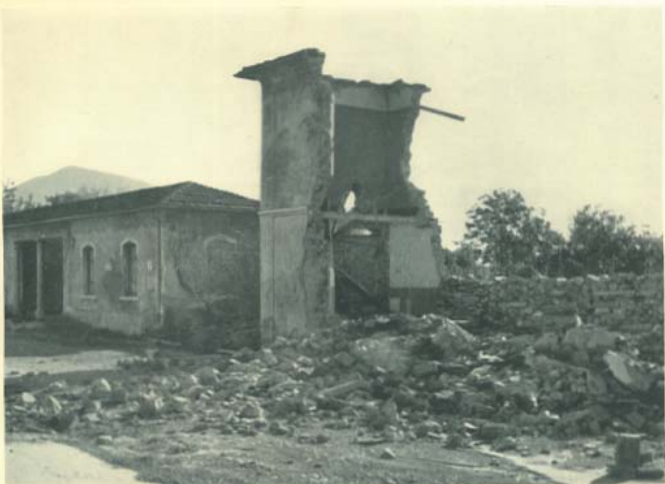
L'ingresso allo Stabilimento dopo l'opera dei quattrotti (dal 17 luglio al 2 agosto 1944)
