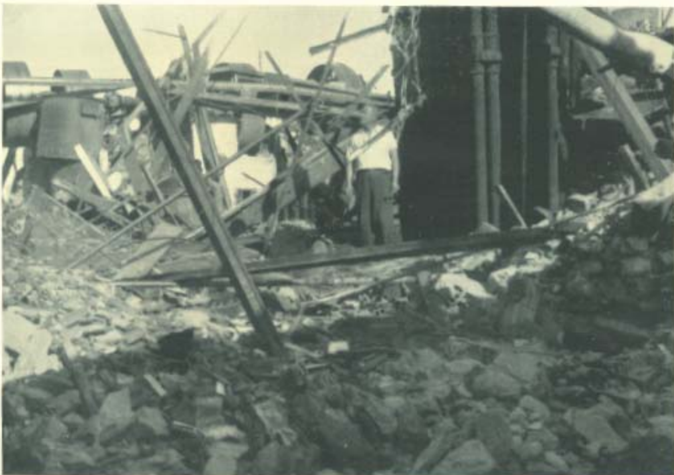
La colata distrutta con potentissime cariche di dinamite
