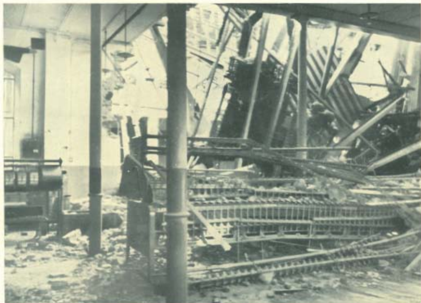
Interno dopo il crollo del soffitto superiore
