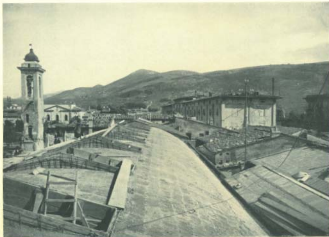
Copertura del salone teatro
