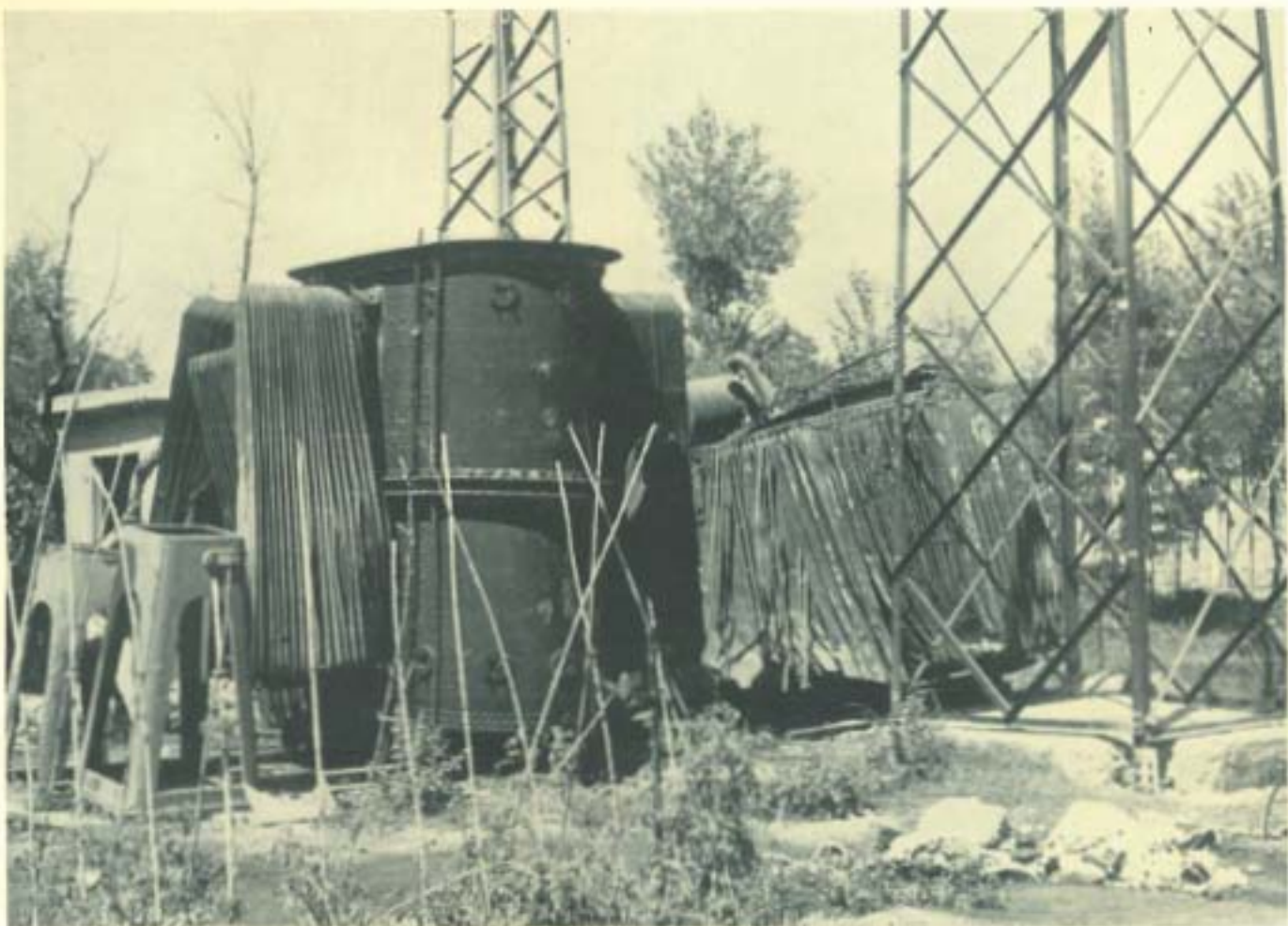
Installazione sussidiaria di Via A. Zatti: trasformatore misto
