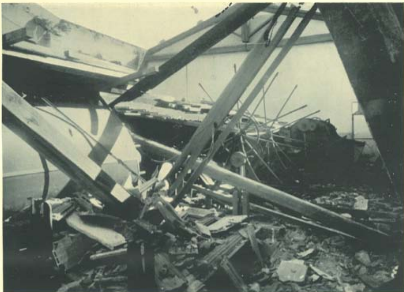
Resti di un ammortizzatore dopo il crollo
