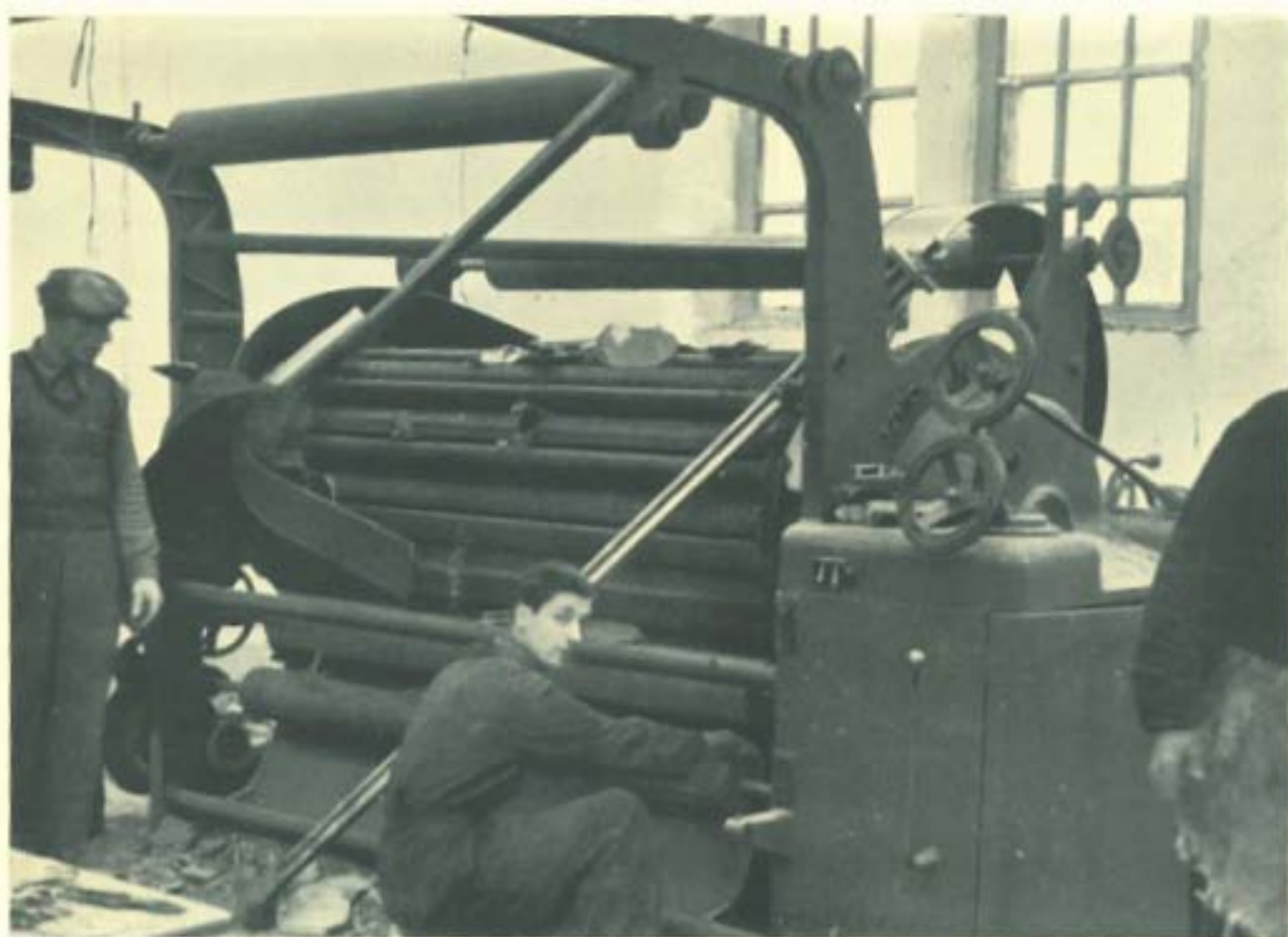
Di lavoro per riparare il gas
