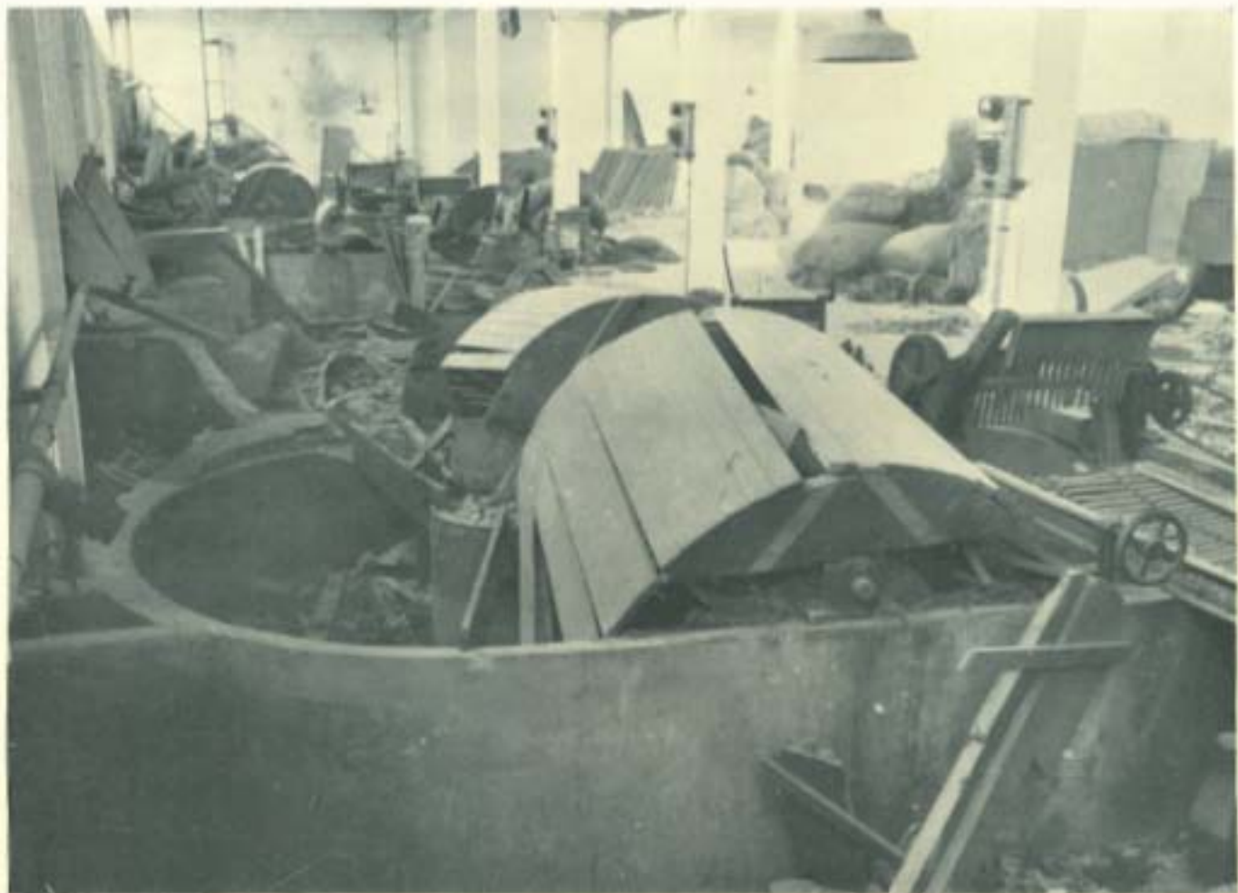
Lavori ricostruttivi iniziati dai tedeschi il 31 luglio 1944
