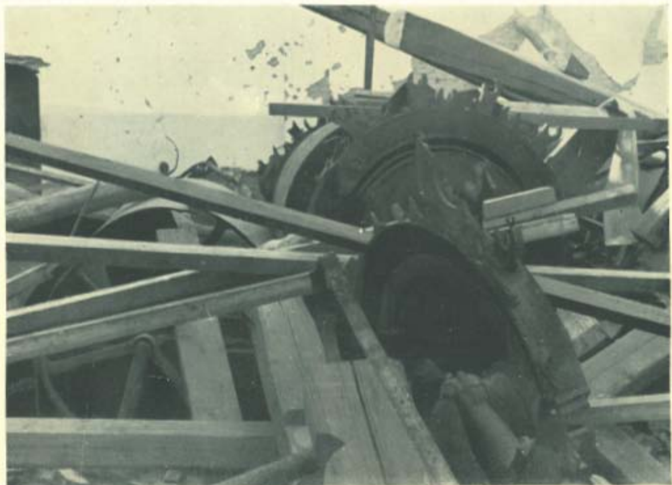
Dopo l'esplosione delle cariche di dinamite (1° agosto 1944)
