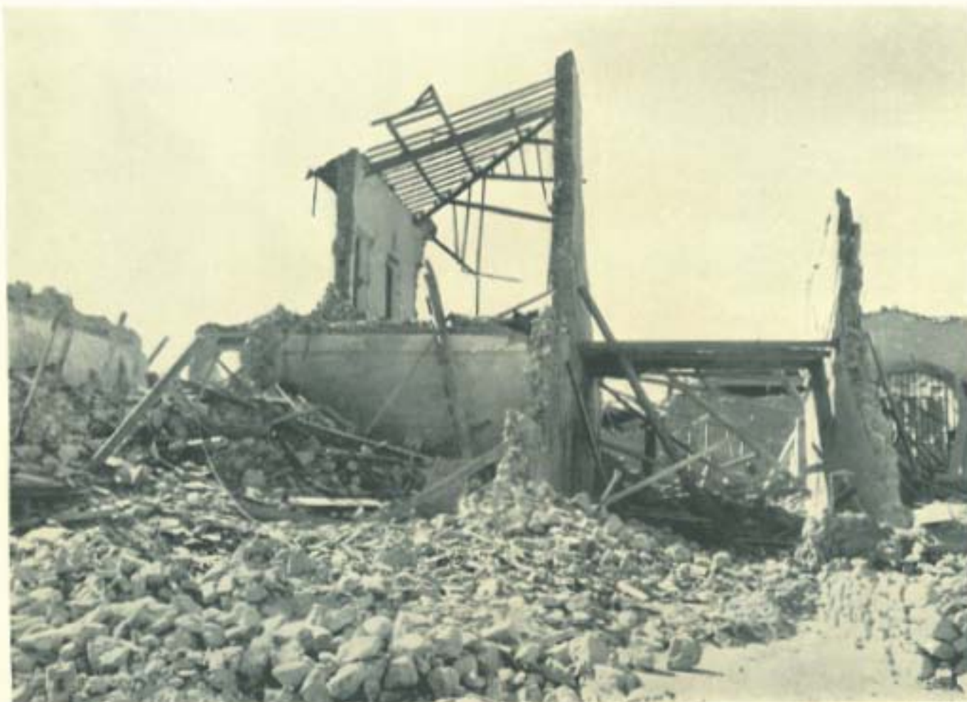
Resti del riparo struttura e confortati
