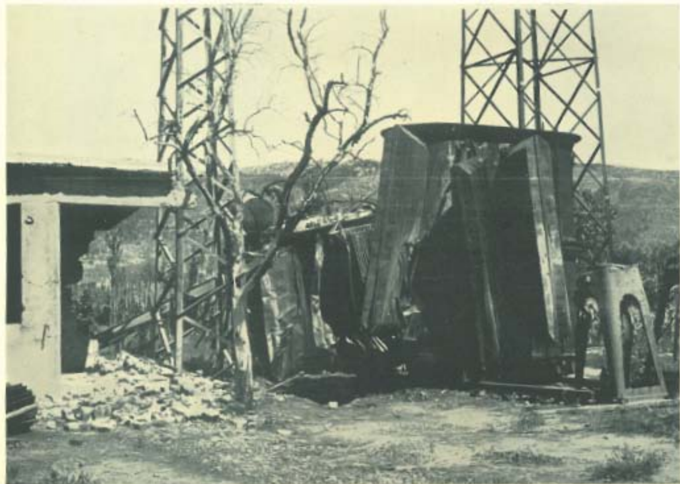
Stazione elettrica di Via A. Zucchi: trasformatori rotti
