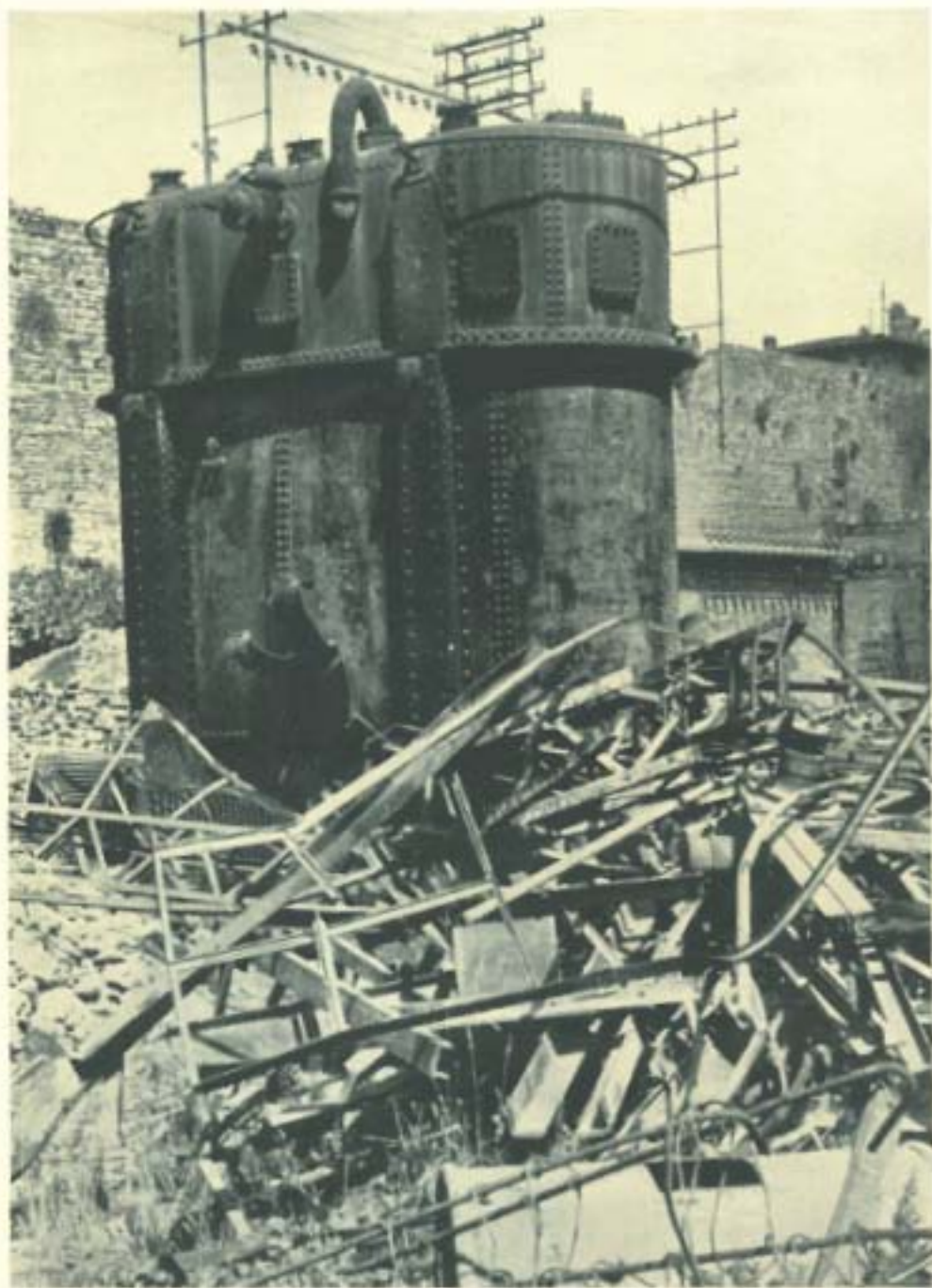
Stazione elettrica di Via A. Zucchi: trasformatori rotti
